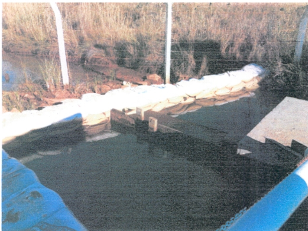
Transposição de água do ribeirão Estiva, para a captação do ribeirão Sujo
