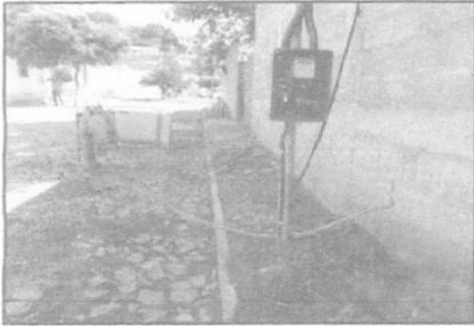
Foto 5: Poço C-04, implantado no período de colapso, 17/10/2014
